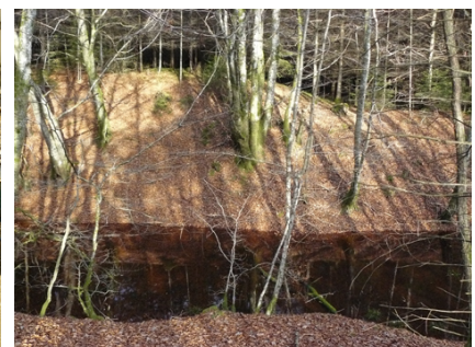
(c) Canal du Touron (Arleuf)
